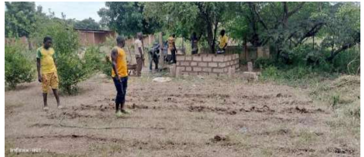
Construction du bassin pour la réserve d'eau
